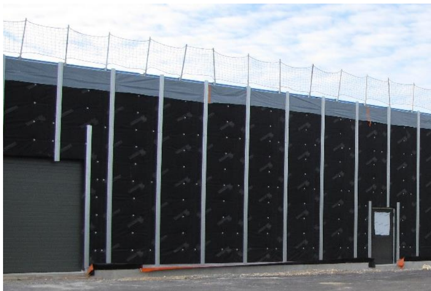
Traitement de l'étanchéité à l'air par film pare-air (en façade) et pare-vapeur (en toiture)
