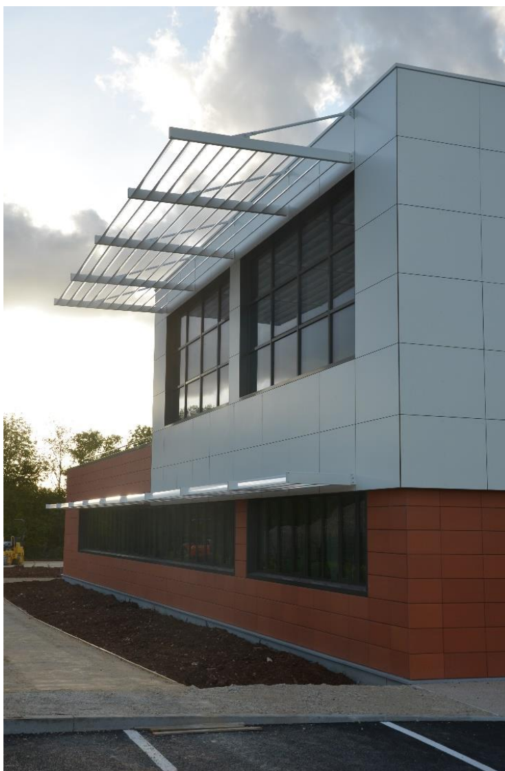
Brise-soleil horizontal sur façade Sud
