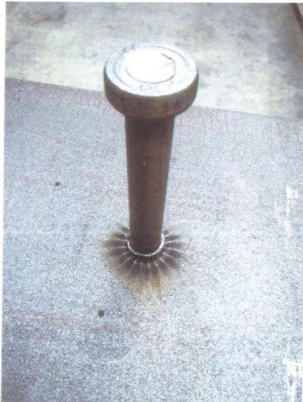
Photo 2 : Détail de la pose du goujon Nelson
