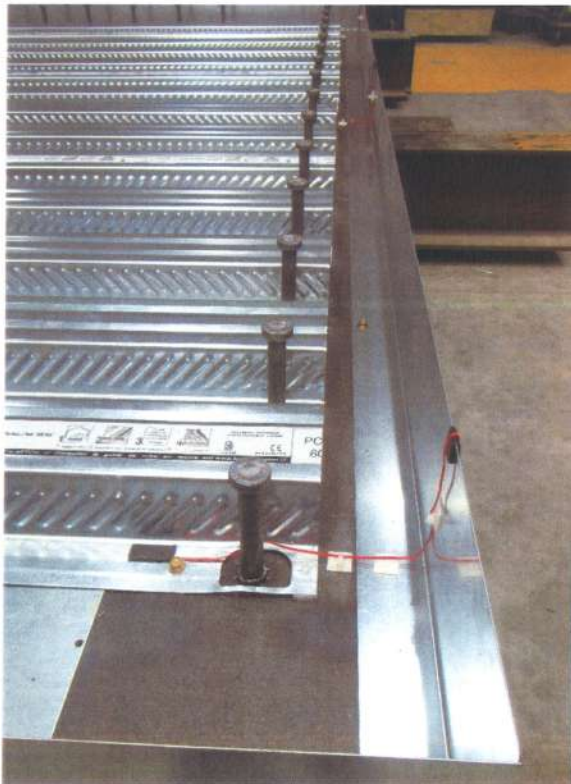
Photo 5 et 6 : Détail de la pose des bacs
