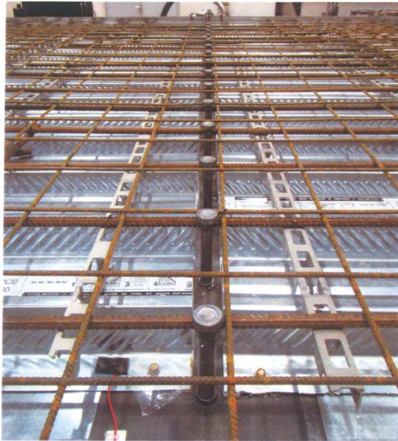
Photo 15 : Détail de la pose des barres centrales
