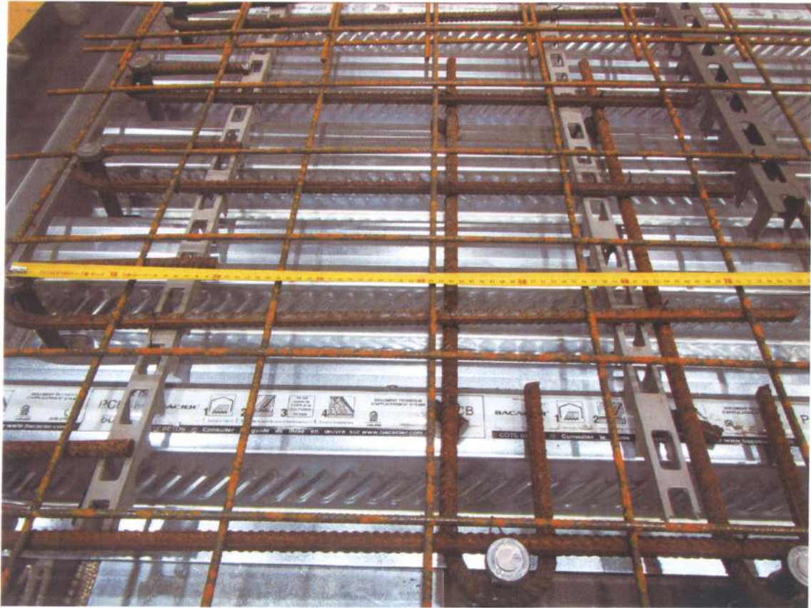
Photo 10 : Détail de la pose des crosses - longueur
