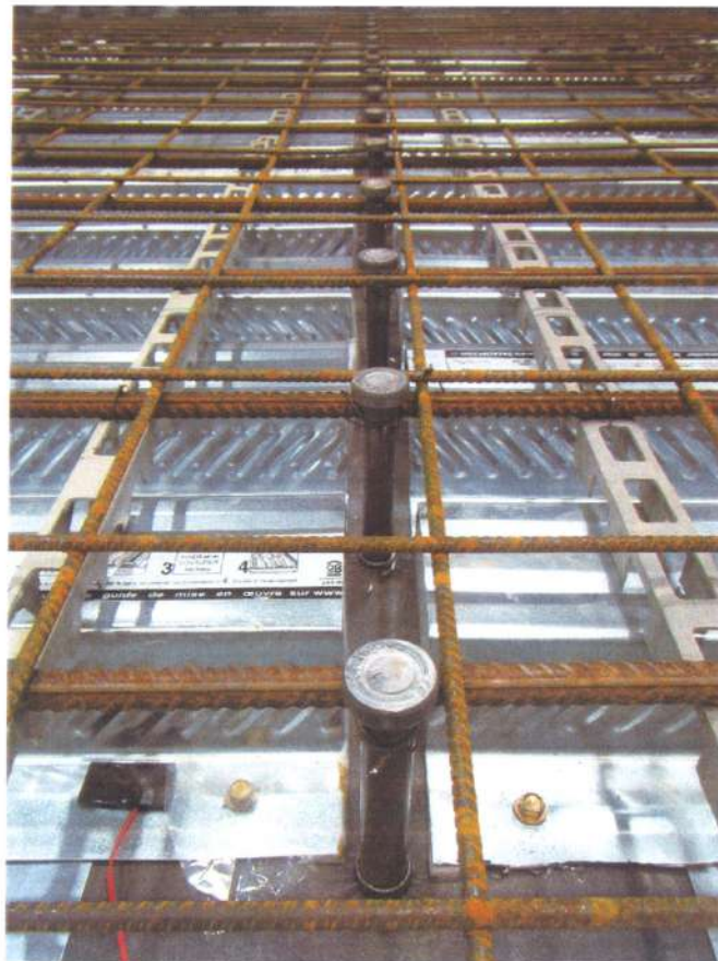
Photo 11 : Détail de la pose du treillis
