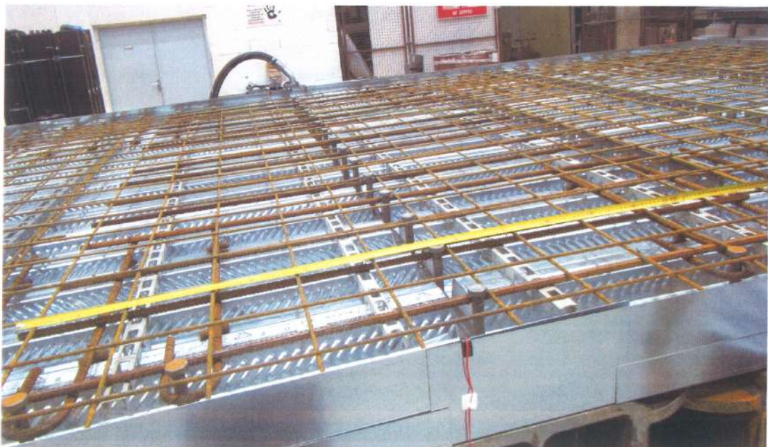
Photo 16 : Détail de la pose des barres centrales – Mesure de la longueur
