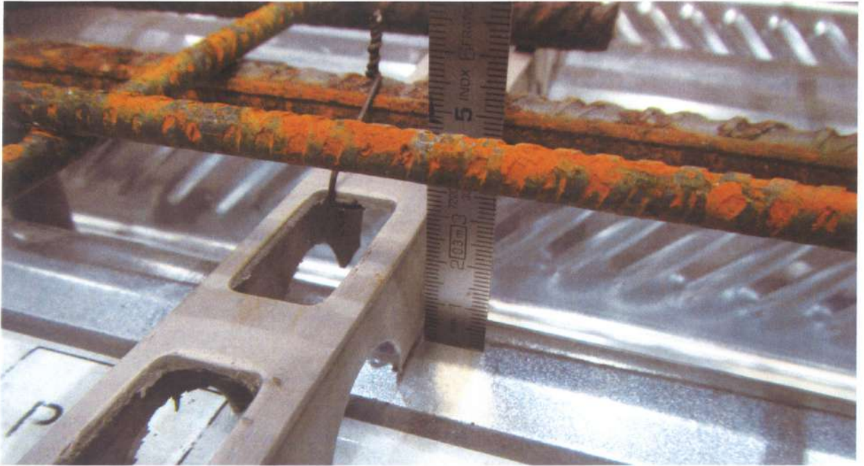
Photo 12 : Détail de la pose des treillis - calage
