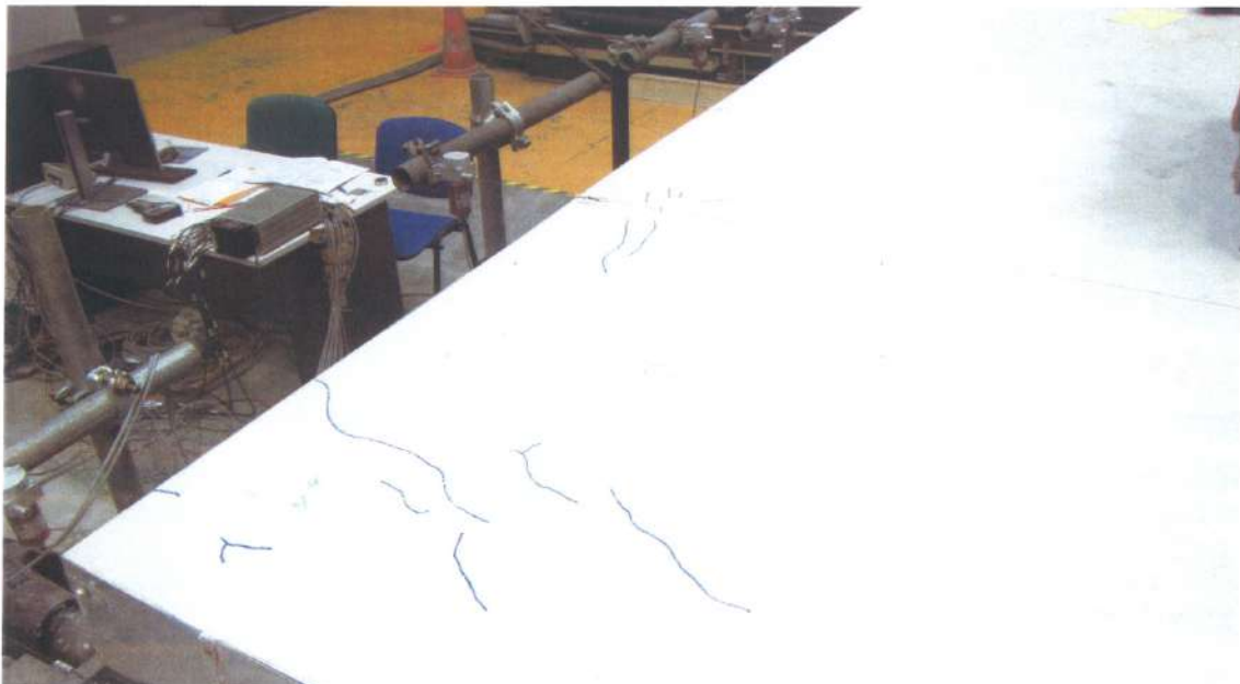
Photo 35 : Détail de la fissuration au niveau de l'application de l'effort
