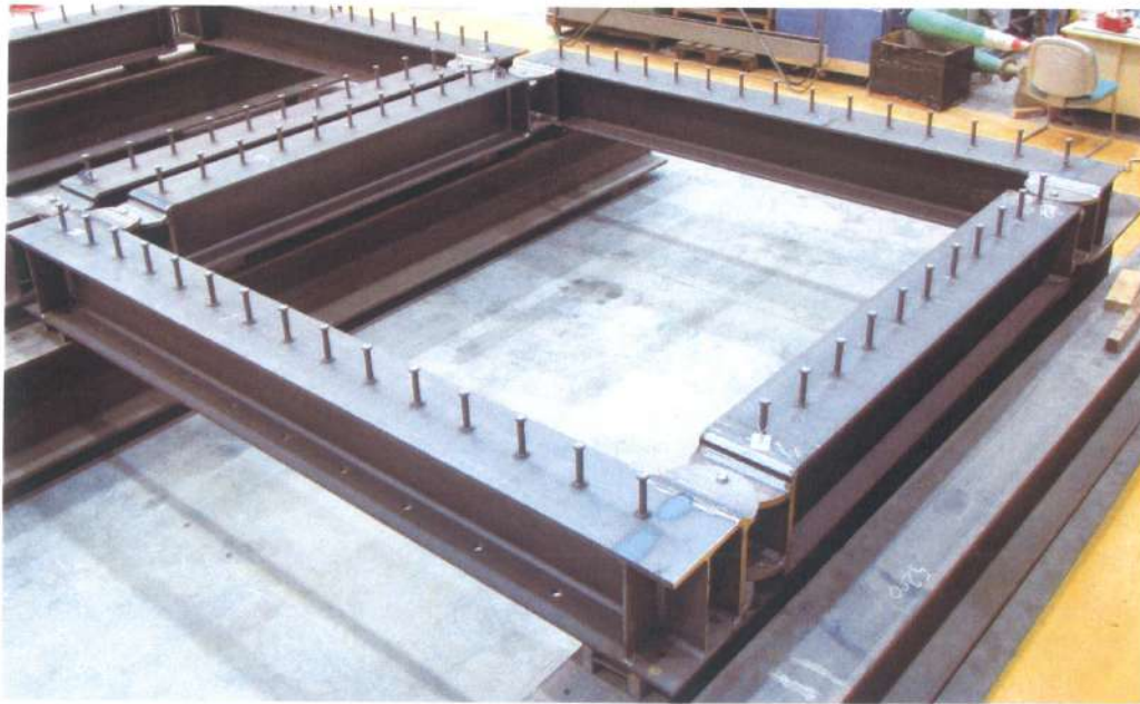
Photo 1 : Vue globale de la structure d'accueil
