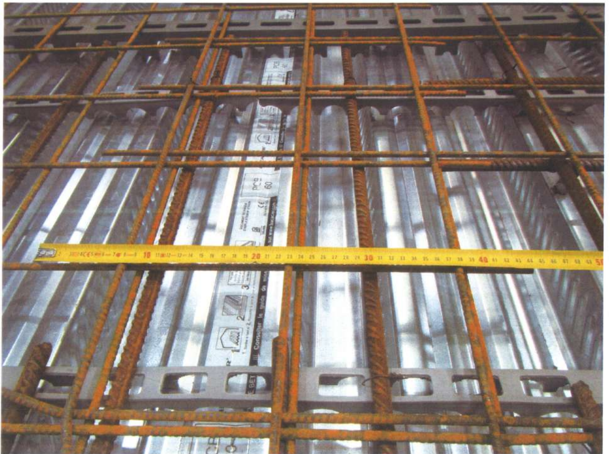
Photo 13 : Détail de la pose des treillis - Recouvrement
