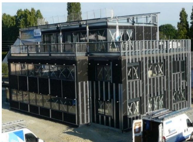
Traitement de l'étanchéité à l'air par fil pare-air (en façade) et pare-vapeur (en toiture)
