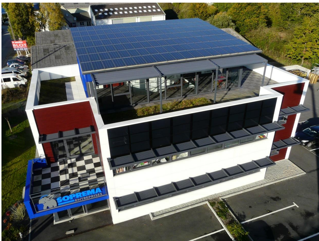
Modules photovoltaïques intégrés à la toiture
