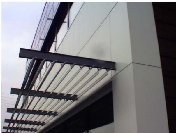
Brise-soleil horizontal sur façade Sud
