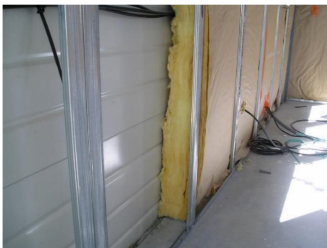
Bardage double peau avec doublage intérieur isolant
