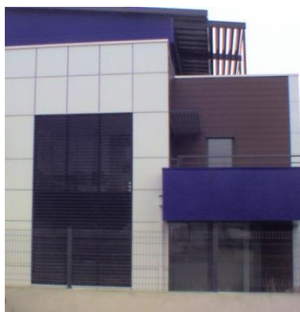
Brise-soleil vertical sur façade Ouest
