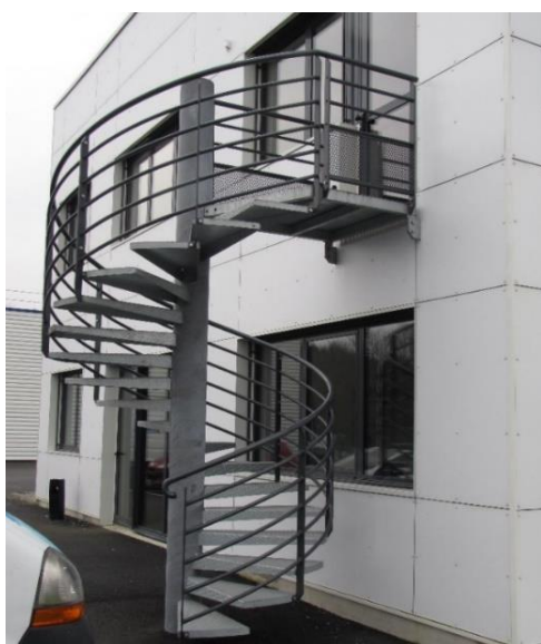
Escalier métallique extérieur
